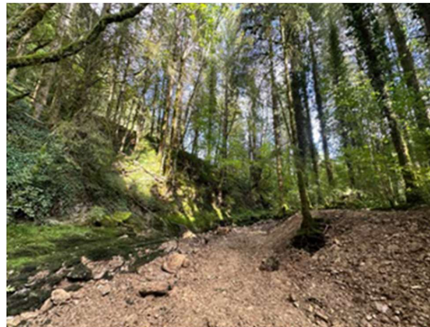
Seuil aval dérasé et conduite enlevée
