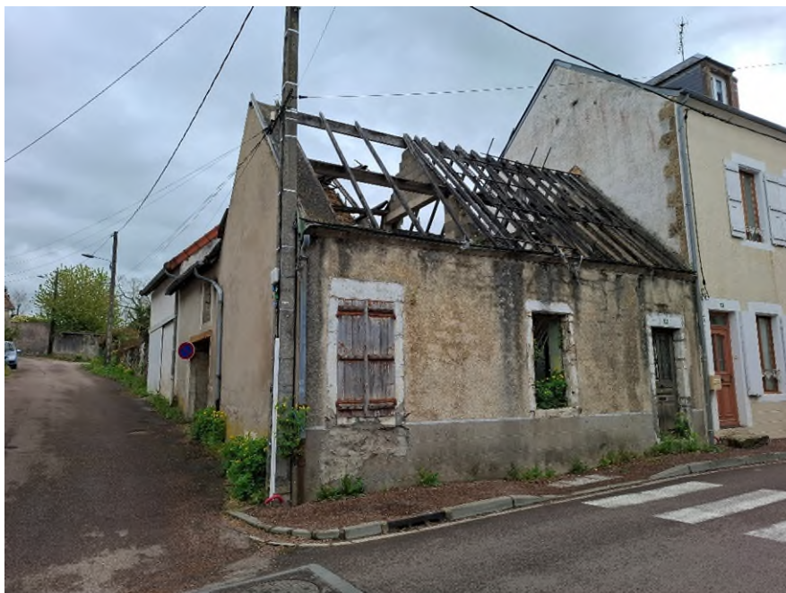
Figure 2 Photo du bâtiment 15 Fbg de Châtillon (prise le 15/04/2025)
