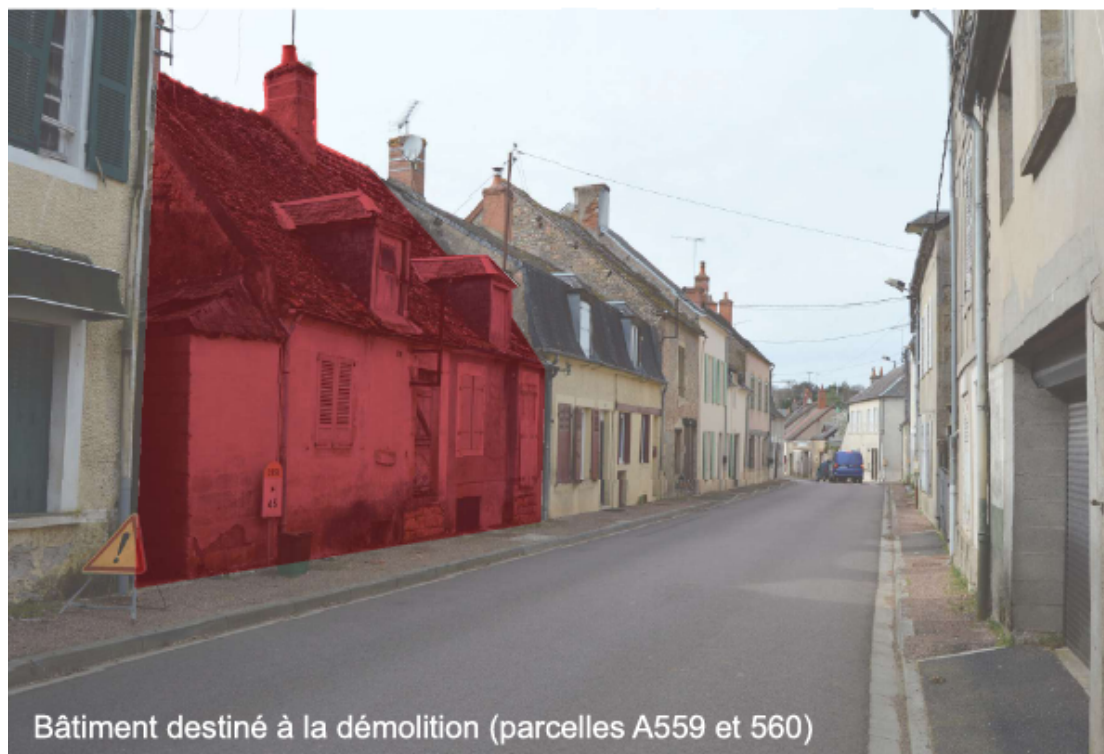
Figure 6 Démolition des parcelles A559-560
