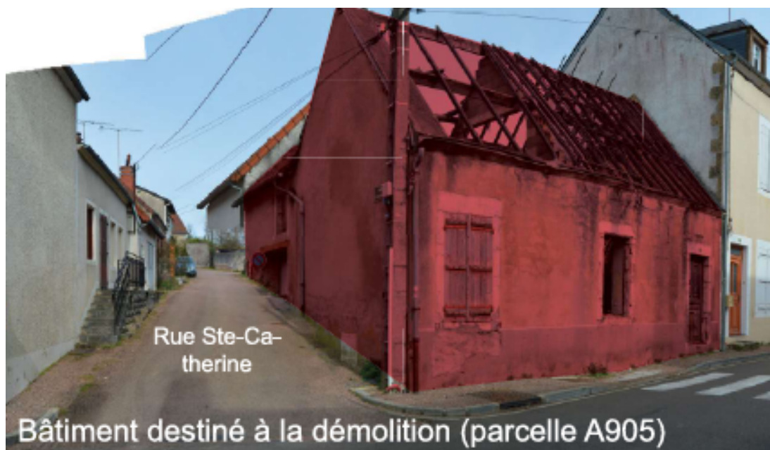
Figure 7 Démolition de la parcelle A905
