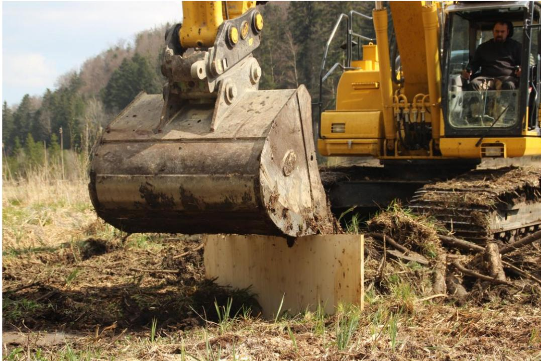
*Panneau en bois triplis, implanté perpendiculaire à l'écoulement*
