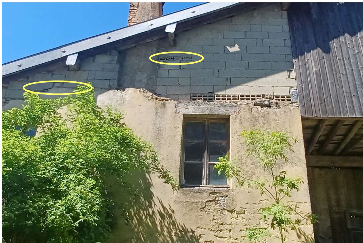
Figure 9: • Parpaing creux en façade extérieure
