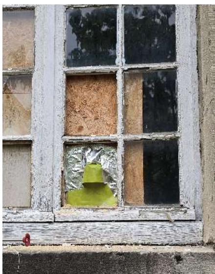
Figure 20 : exemple de système anti- retour
