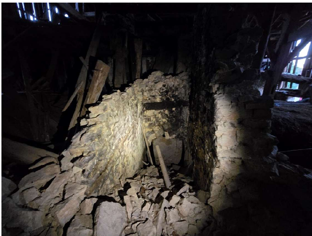
Figure 12 : Accès à l'une des caves, en cours d'effondrement
