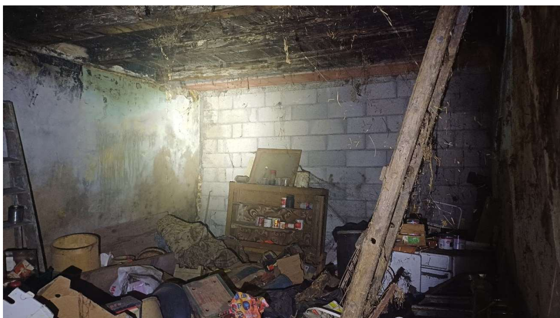
Figure 12 : Accès à l'une des caves, en cours d'effondrement
