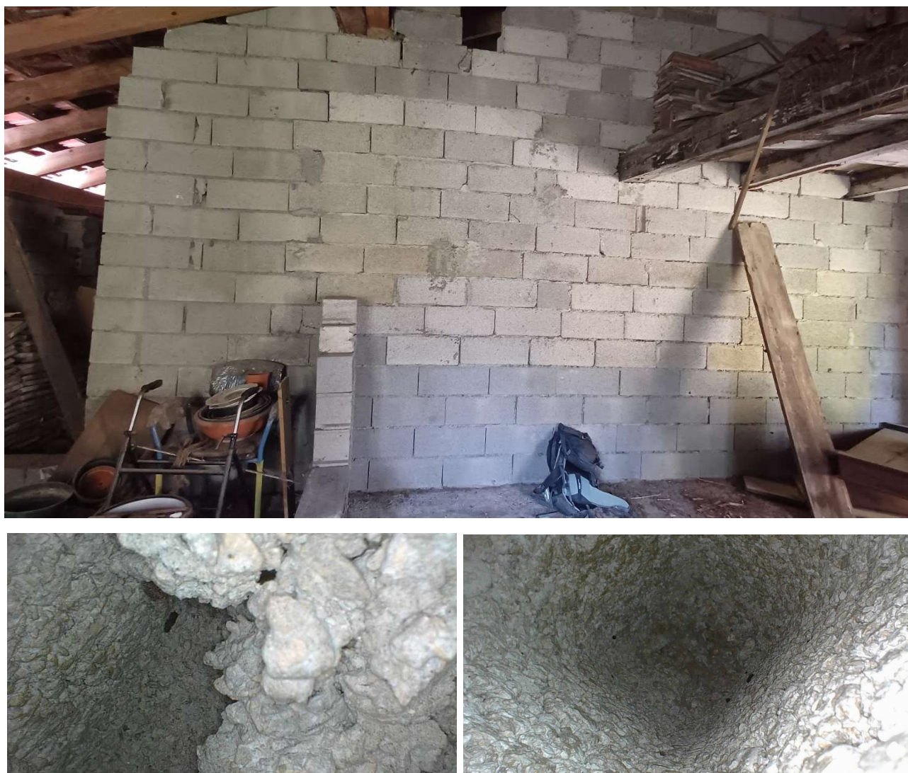
Figure 13 : Parpaing creux avec guano, à l'endoscope
