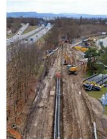
Raccordement au réseau de chauffage urbain de la ville de Saint-Louis (biomasse)
