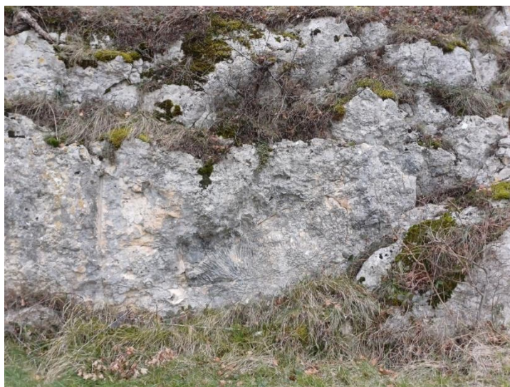
Illustration 5 : Affleurement de la voie ferrée à proximité du début de sentier d'interprétation
