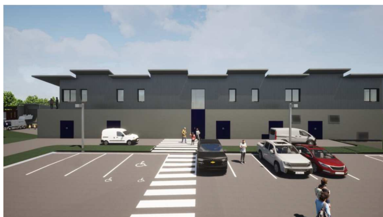
Figure 26 : Extension des bureaux et des locaux sociaux (façade nord)
