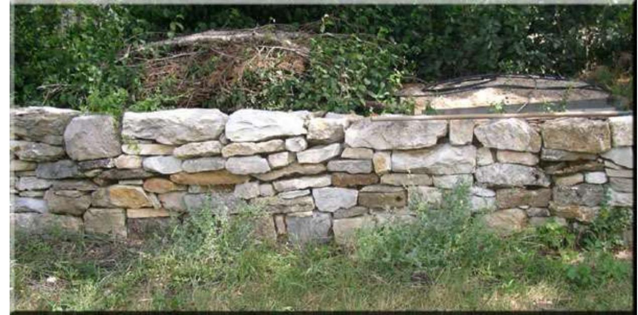
Figure 39 : Illustration d'un mur en pierre sèche
