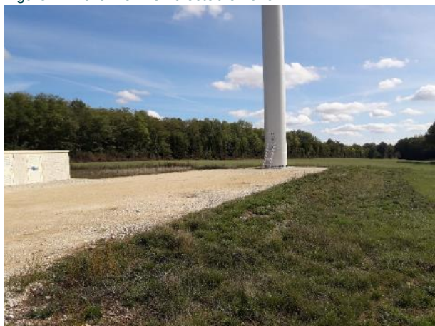
Figure 9 : Éolienne 9 le 10 octobre 2019
