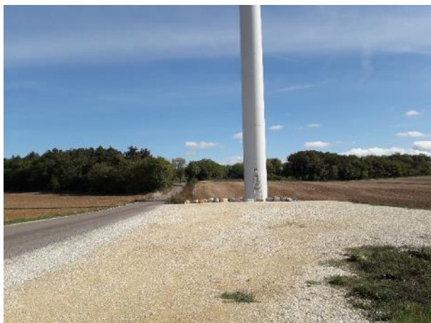
Figure 5 : Éolienne 5 le 10 octobre 2019
