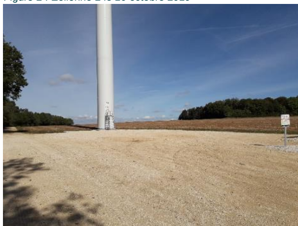
Figure 4 : Éolienne 4 le 10 octobre 2019
