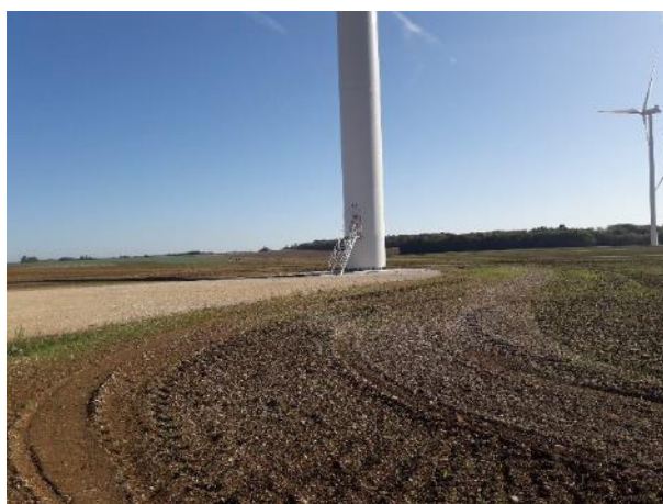
Figure 2 : Éolienne 2 le 10 octobre 2019
