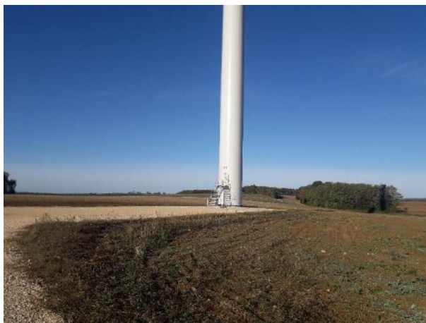
Figure 6 : Éolienne 6 le 10 octobre 2019
