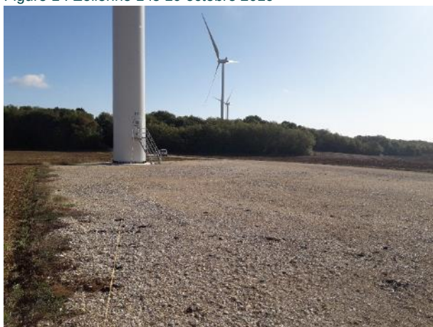
Figure 3 : Éolienne 3 le 10 octobre 2019
