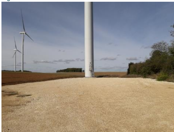
Figure 8 : Éolienne 8 le 10 octobre 2019
