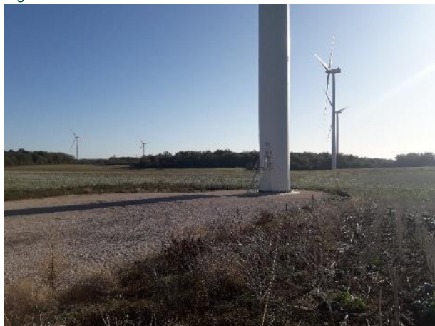
Figure 7 : Éolienne 7 le 10 octobre 2019
