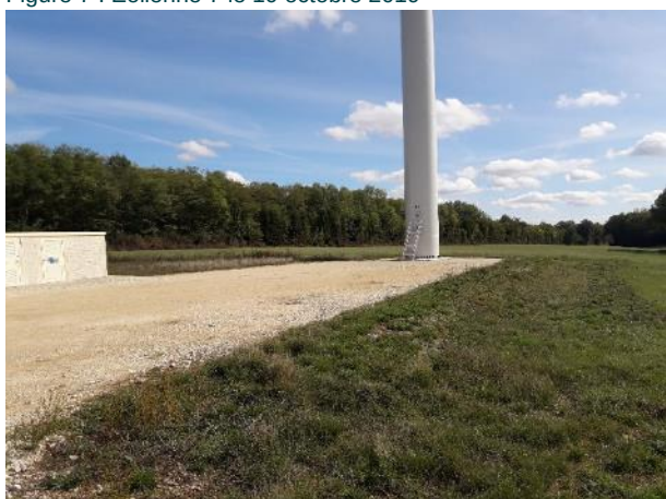
Figure 9 : Éolienne 9 le 10 octobre 2019
