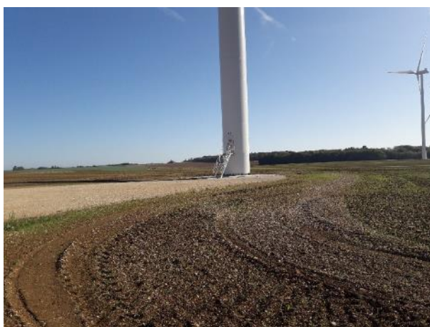
Figure 2 : Éolienne 2 le 10 octobre 2019
