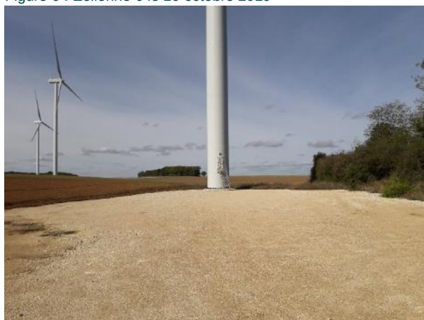
Figure 8 : Éolienne 8 le 10 octobre 2019
