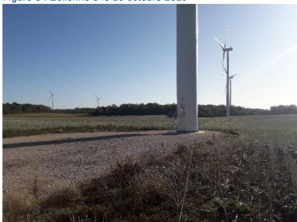
Figure 7 : Éolienne 7 le 10 octobre 2019
