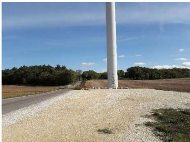
Figure 5 : Éolienne 5 le 10 octobre 2019
