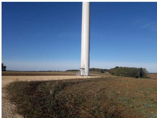
Figure 6 : Éolienne 6 le 10 octobre 2019
