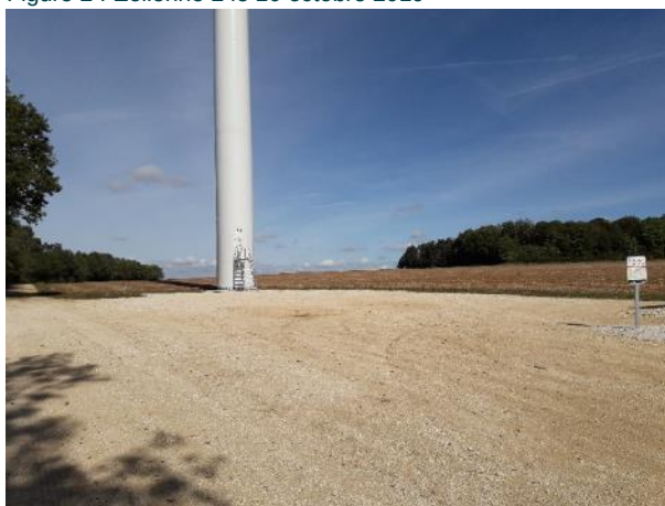
Figure 4 : Éolienne 4 le 10 octobre 2019
