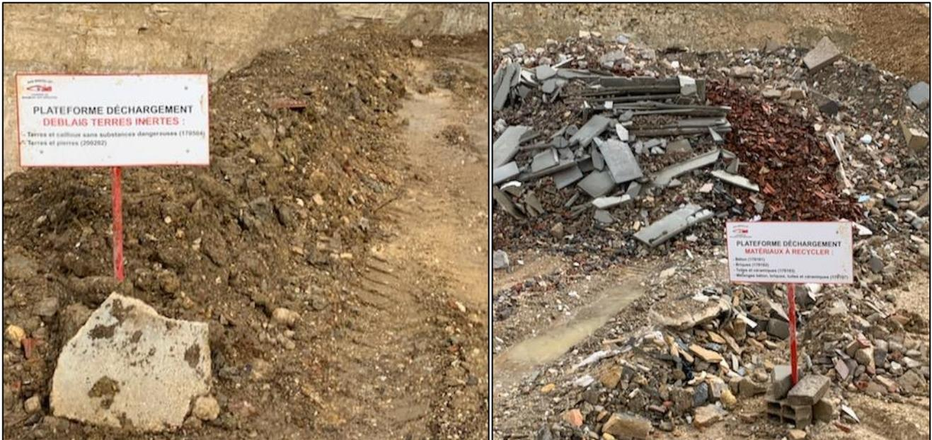
Photographie 11 : Plateformes de déchargement de déchets inertes et matériaux à recycler
