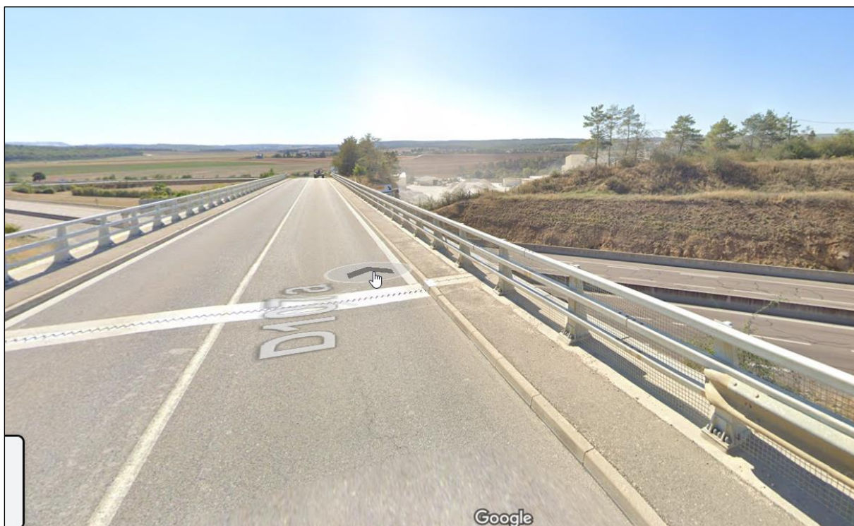
Photographie 4 : Pont traversant la RD906 - Surface cédée au Conseil Départemental - Une partie de l'emprise du pont et du bas coté de la RD906 sera soustraite du périmètre (Google Map, sept. 19)
