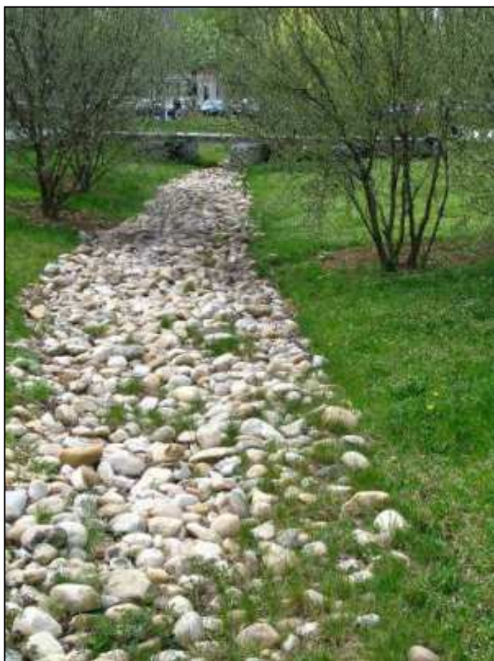
Figure 5 : Exemple de noue d'infiltration
