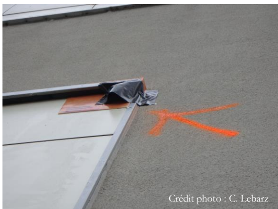
Figure 14 : Exemple de système anti-retour équipée d'une casquette anti-retour
