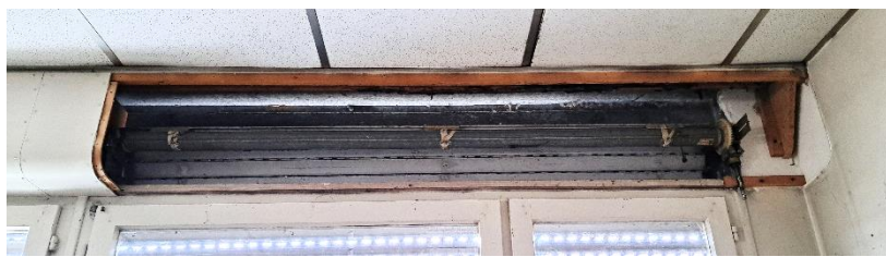
Figure 21 : Caisson de volet roulant manquant vu depuis l'intérieur du bâtiment
