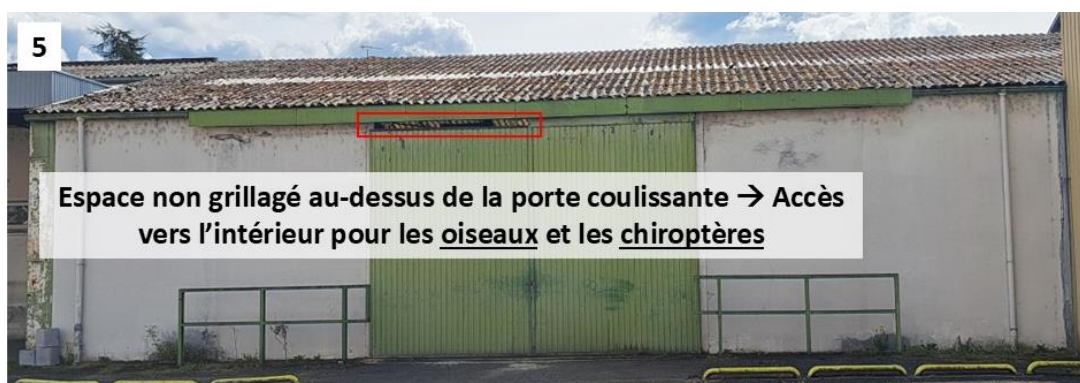
Figure 22 : Potentialité d'accueil sur la façade nord-nord-est de l'unité 5 permettant aux oiseaux et aux chiroptères d'accéder à l'intérieur du bâtiment
