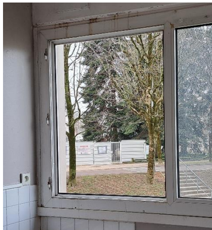
Figure 2 : Fenêtre manquante permettant à des animaux d'accéder à un logement
