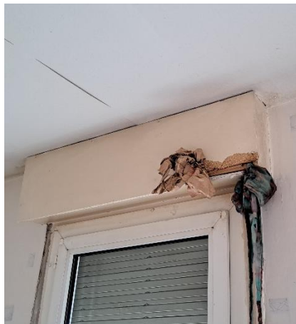
Figure 3 : Caisson de volet roulant endommagé et dont les trous ont été bouchés grâce à des déchets trouvés sur place
