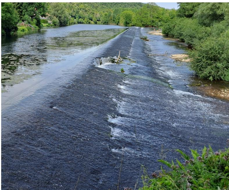
Figure 14 : Dégradation du seuil de dérivation
