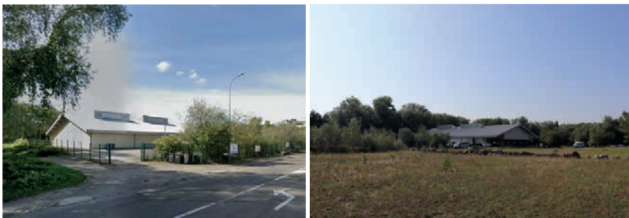
13. Photos du bâtiment canoë-kayak - photos de Google Earth et Territoires
