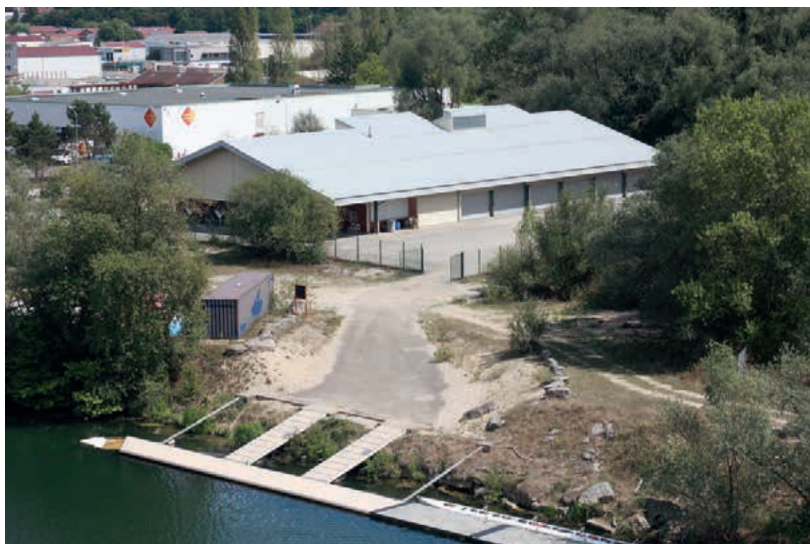
184. Bâtiment kayak vu depuis le pont de la corniche
