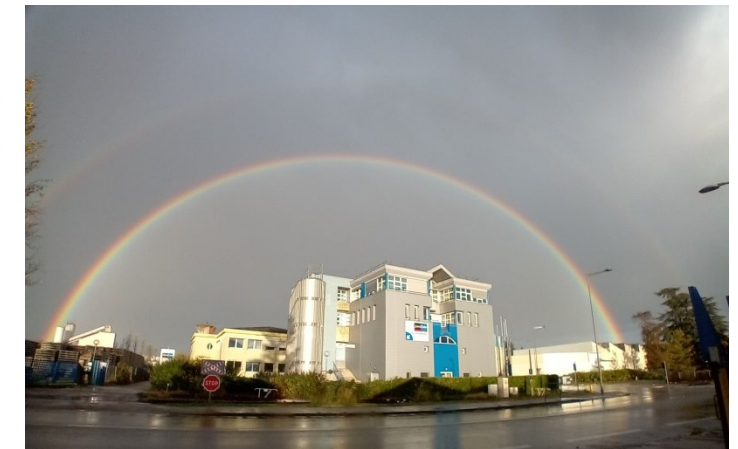
Parking privé + bâtiment Pôle Environnement
