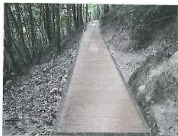
platelage bois (lames de 12 mm x 3 mm x largeur structure) ; platelage en caillebotis métallique ; platelage mixte
