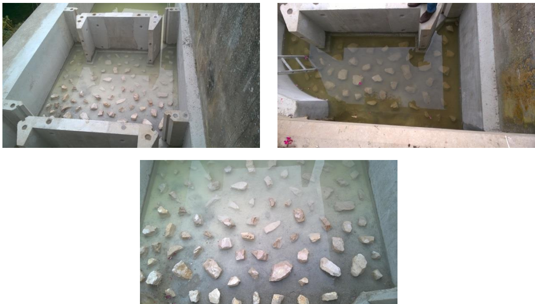
Fig. 36. Mise en œuvre de la rugosité de fonds - Mirebeau-sur-Bèze
