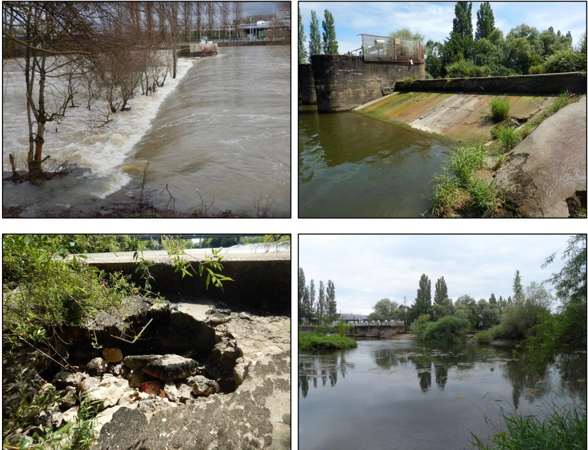
Fig. 4. Barrage des Bréviers
