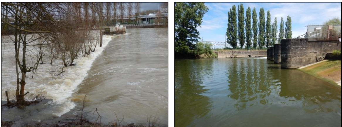
Fig. 7. Photos du barrage des Bréviers
