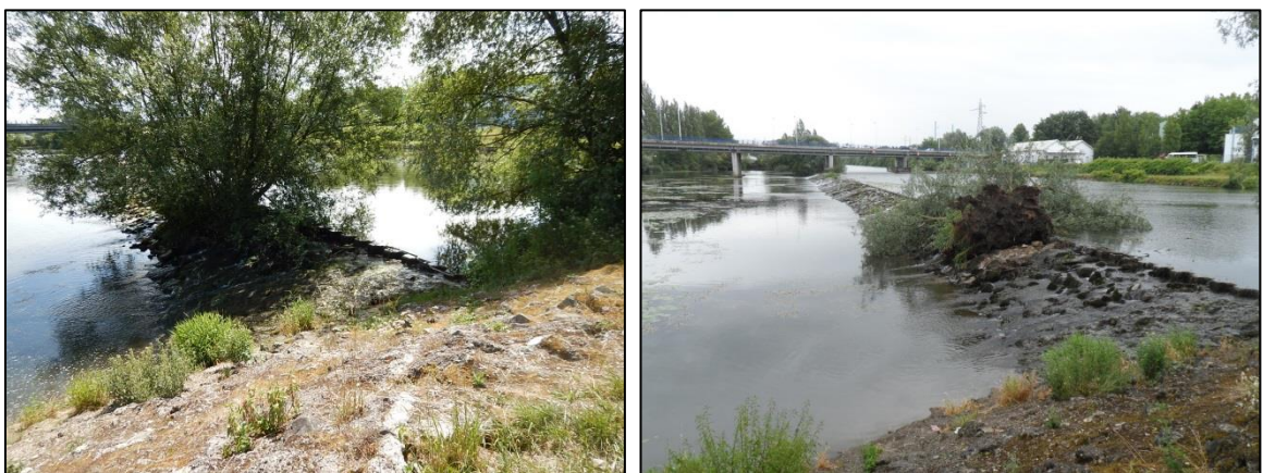
Fig. 3. Barrage du Ludwigsburg
