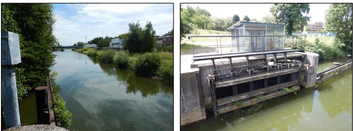
Fig. 8. CRR et porte de garde
