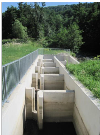
Fig. 25. Passe à fentes verticales (une fente) Franchissement du barrage de Mutzig sur la Bruche (MOE ARTELIA)
