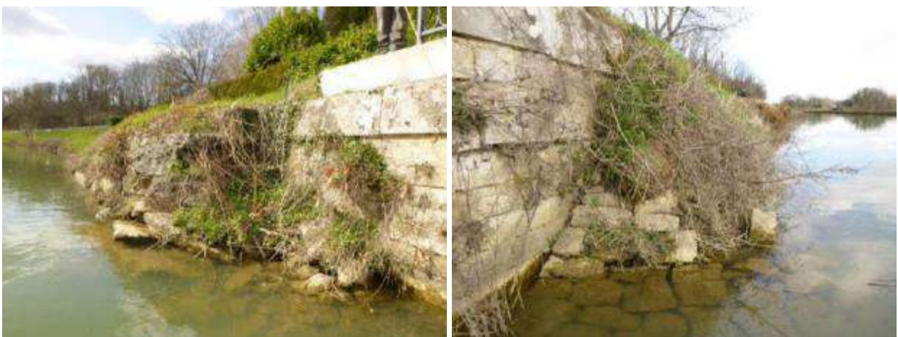
Figure 23. Etat général de l'ouvrage d'art
