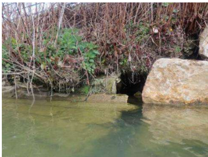
Figure 46. Cavité actuelle au niveau de la jonction enrochements/perré maçonné (source : TMI, 2023)
