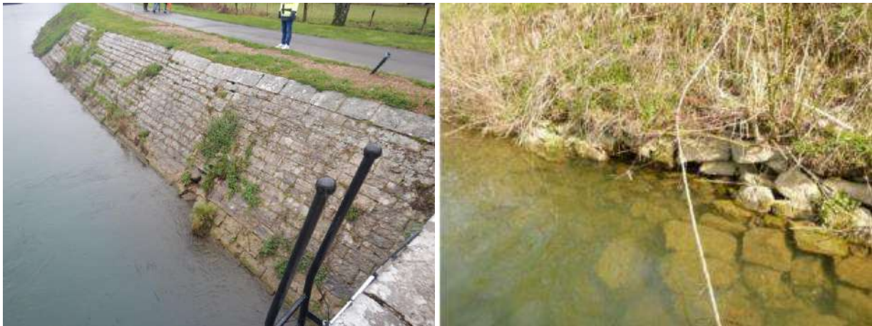
Figure 19. Etat général des perrés maçonnés
