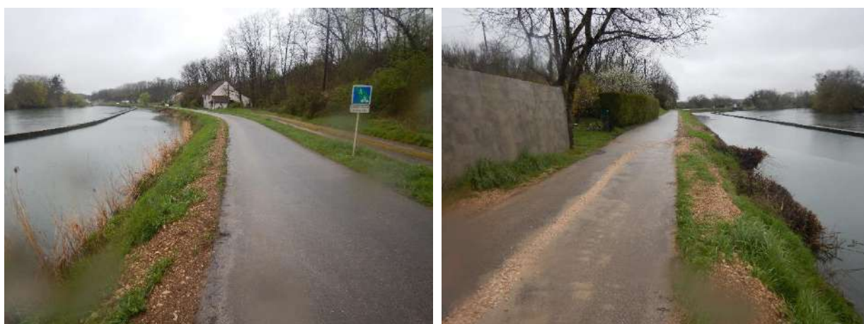
Figure 50. Etat général du chemin de halage
