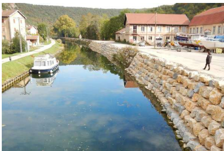
Figure 45. Exemple de protection de berge en enrochements tabulaires
