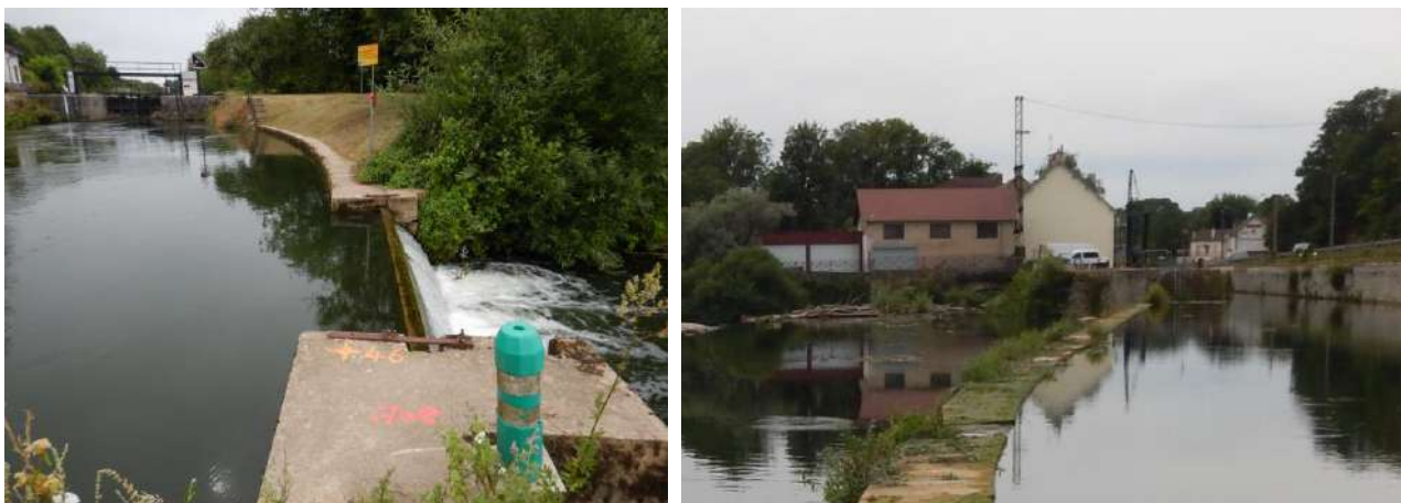
Figure 5. Déversoir de décharge du mur du moulin des Malades
