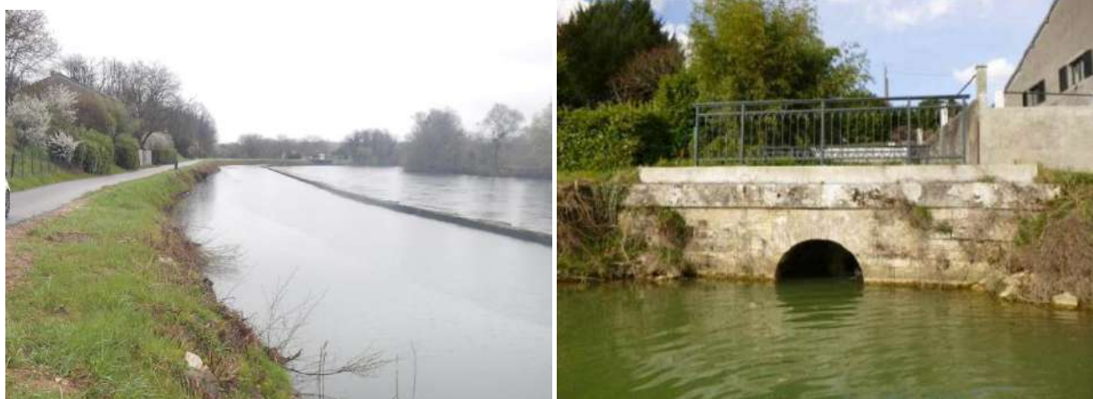
Figure 6. Section courante de la berge en rive droite du bief 61/62 (à gauche) et ouvrage d'art (à droite)
