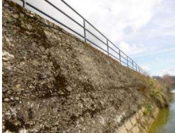
Figure 22. Etat général du béton cyclopéen
