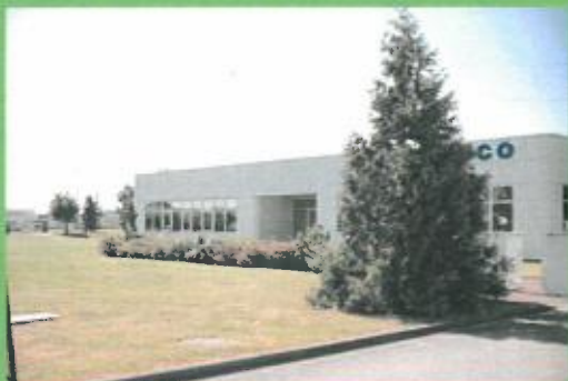
Plantation des soubassements et des façades avant.
