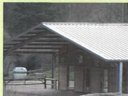
Toiture à doubles pans
