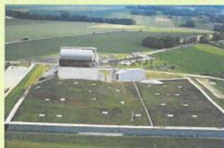
Toiture terrasse végétalisée
