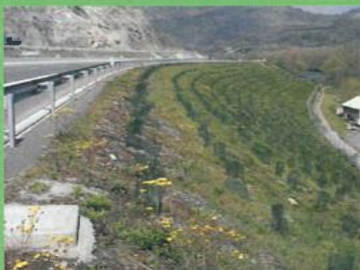
Talus à fort dénivelé, enherbée et planté de d'arbustes.
