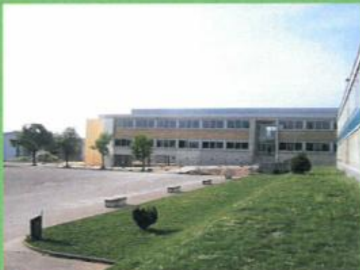
Talus de faible pente végétalisé.
