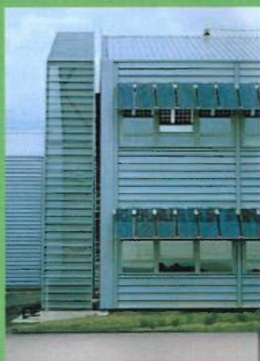
Des panneaux photovoltaïques semi transparent servent de pare-soleil.
