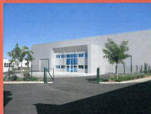
Absence de signalétique : illisibilité de l'entreprise.
