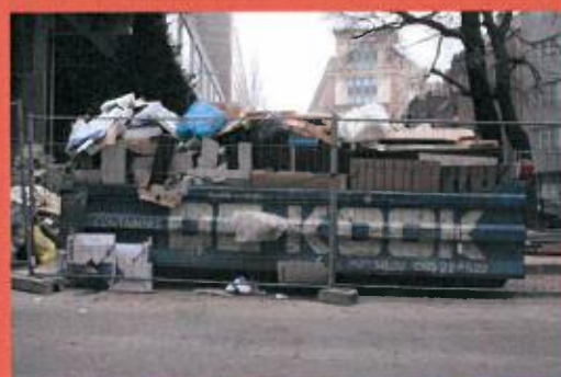
Benne surchargée, contenant plusieurs catégories de déchets et intransportable sans risque d'éparpillement.
