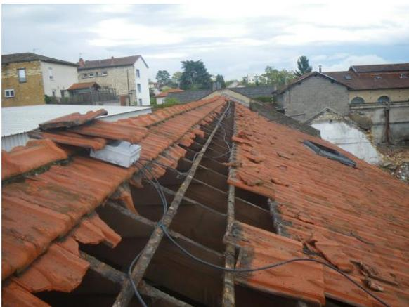
**Photo n°8. Démontage de toiture afin d'éviter un retour au gîte**
