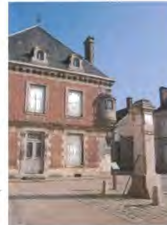
Place du Puits de Fer
