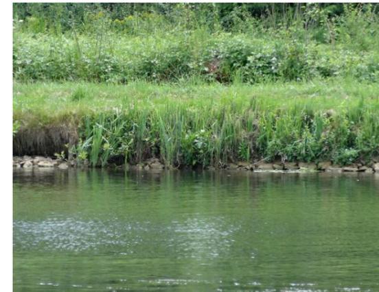
Protection par enrochements et tunage bois en rive gauche
