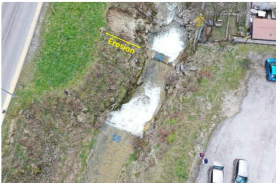
Figure 6 - érosion à l'aval du seuil S6 - vue drone
