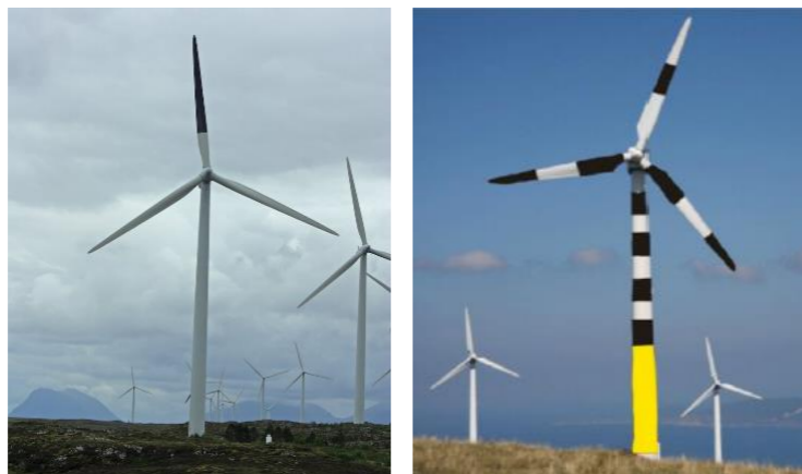
Figure 22 : Différentes méthodes de mise en évidence des éoliennes pour augmenter leur visibilité par les oiseaux.
