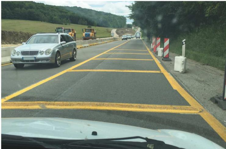
L'objectif de cet équipement est de sécuriser la sortie de la piste de chantier sur la RN57 : en effet, depuis le démarrage des travaux, des vitesses excessives ont été observées à cet endroit, entraînant des risques réels vis-à-vis des circulations d'engins sortant du chantier. Deux panneaux d'annonce ont été installés en amont pour signaler aux usagers la présence du radar autonome.
