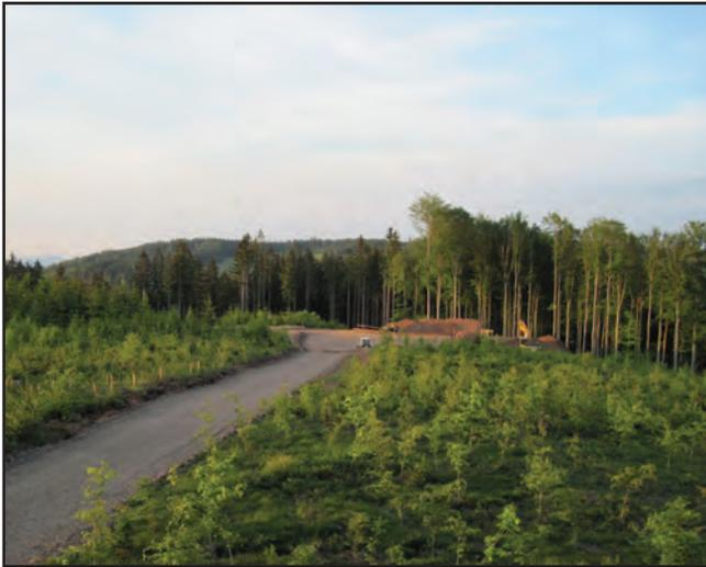
Au pied de chaque éolienne, une plate-forme en remblai est installée afin de permettre et de faciliter les interventions de maintenance.
