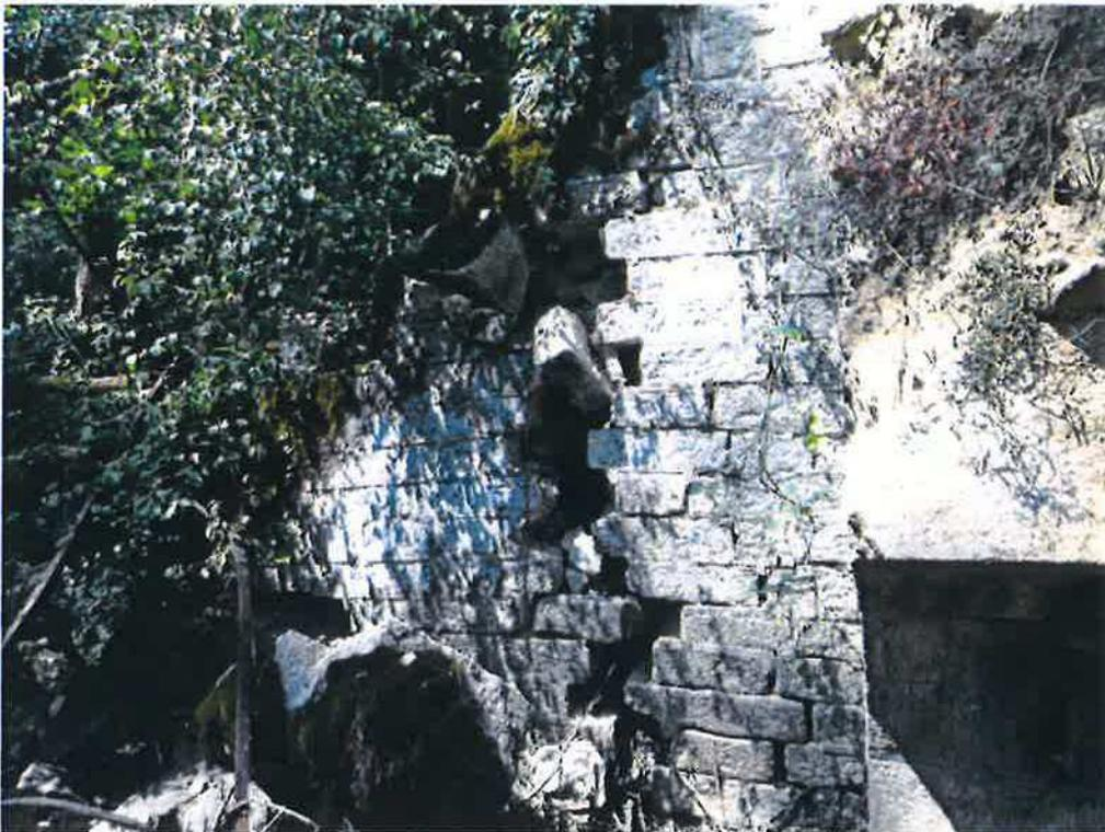
8- Fracture, déversement et basculement du mur en retour aval encore en place côté rive droite
