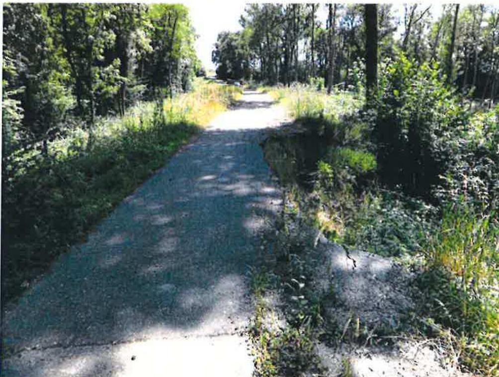
1- Vue générale de la chaussée sur l'ouvrage en direction de Froideville : effondrement de la demi-chaussée côté aval
