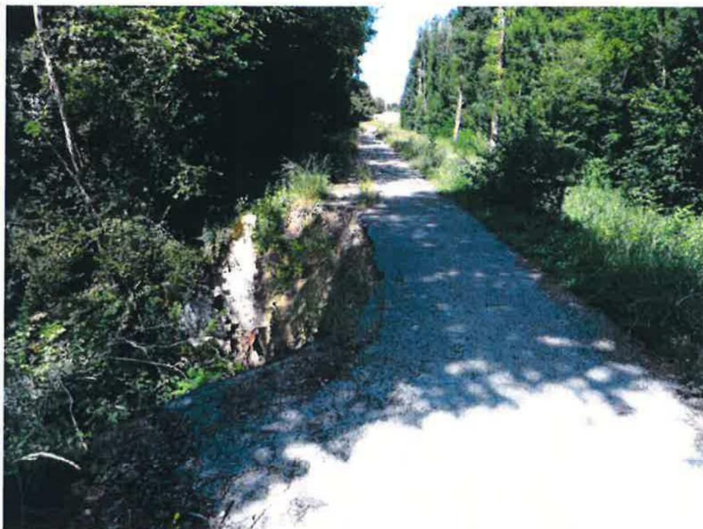
2- Vue générale de la chaussée sur l'ouvrage en direction de Bois-de-Gand : effondrement de la demi-chaussée côté aval
