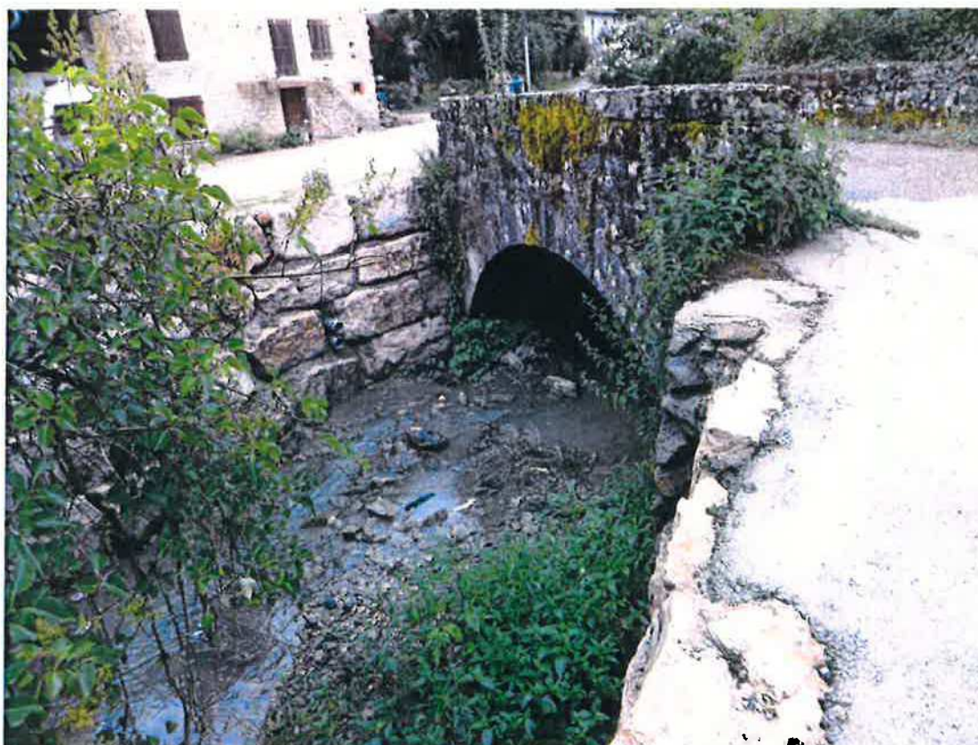
Photo 1 : vue d'ensemble du pont depuis l'aval / environnement aval
