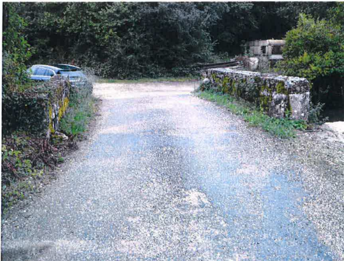
Photo 3 : vue d'ensemble de la chaussée sur le pont depuis la rive droite
