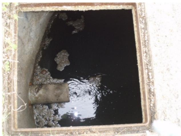
**Figure 4 : Le décanteur-digesteur d'Aroz**
