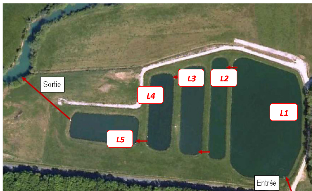
Figure 7 : Photo de la station d'épuration de Pontcey
