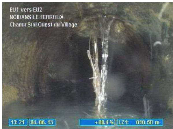
***Figure 13 : Infiltration liée à une perforation***
