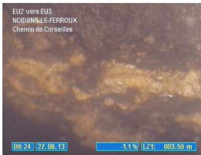
***Figure 14 : Dépôts de graisse constatés chemin de Corseilles***
