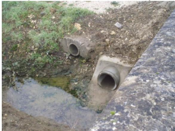
**Figure 7 : Exutoire du collecteur d'eaux pluviales, rue de la Garaude**
