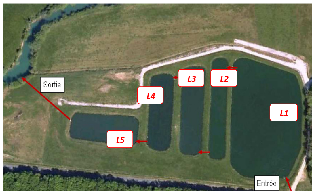
Figure 11 : Photo de la station d'épuration de Pontcey
