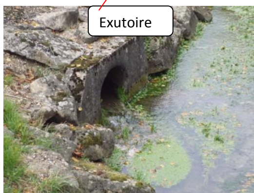
Figure 7 : Réseau d'eaux pluviales de la rue de Vesoul
