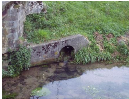
Figure 6 : Exutoire du collecteur d'eaux pluviales de la rue de Canes
