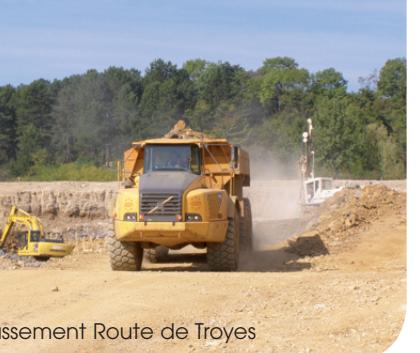
Les matériaux rocheux destinés à la réalisation des couches d'assise de la chaussée sont transportés vers la zone de concassage des Charmes d'Aran. Une fois remis en place, les différents matériaux sont compactés afin de garantir la stabilité des structures. Tous les matériaux de déblai seront réutilisés sur le chantier, l'objectif étant de limiter au maximum les apports extérieurs.
