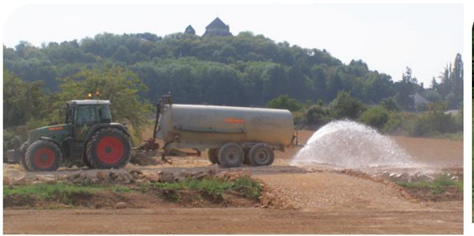
Par temps sec, afin de limiter les émissions de poussières, les pistes sont régulièrement arrosées avec les eaux résiduelles récupérées sur le chantier. Par ailleurs, l'organisme Atmosph'air a été chargé de la mise en place de collecteurs et capteurs pour mesurer la qualité de l'air, notamment la teneur en particules.
