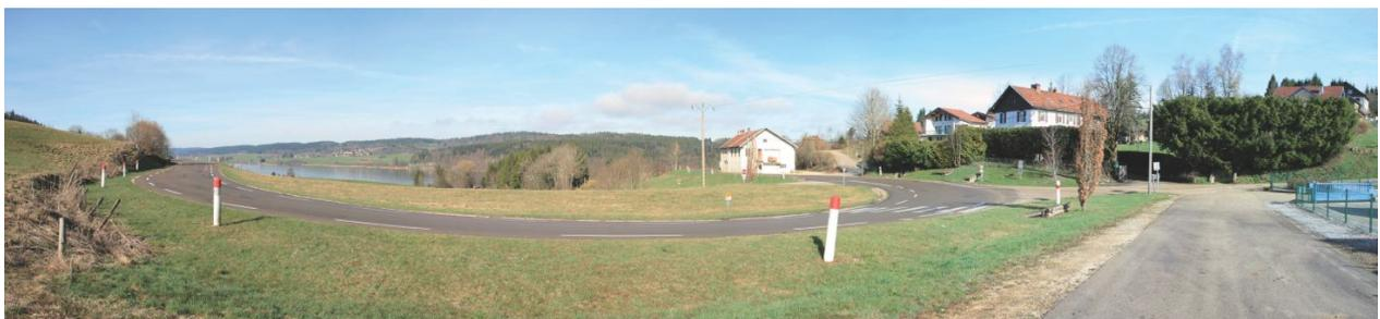
Suite à l'esquisse préliminaire de l'ensemble du carrefour, l'aménagement porte sur l'aménagement de la rue du centre et RD 437. Il s'agit de sécuriser le carrefour pour les véhicules descendant de la rue du centre et s'insérant sur la RD 437. Pour cela des bordures seront mise en place pour matérialiser le bord de chaussée. Un cheminement piéton en stabilisé sera mise en place. Quelques plantations d'arbres tiges seront mise en place matérialisant le carrefour.
