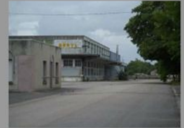
Photo d'ensemble du site
