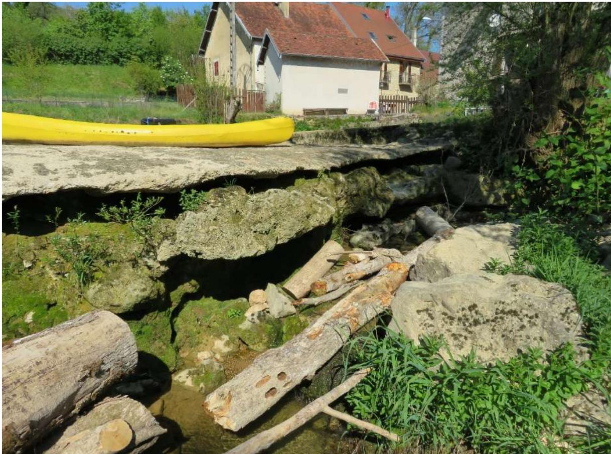
*Figure 53 : Affouillement de la partie de seuil au droit du canal d'aménée*
