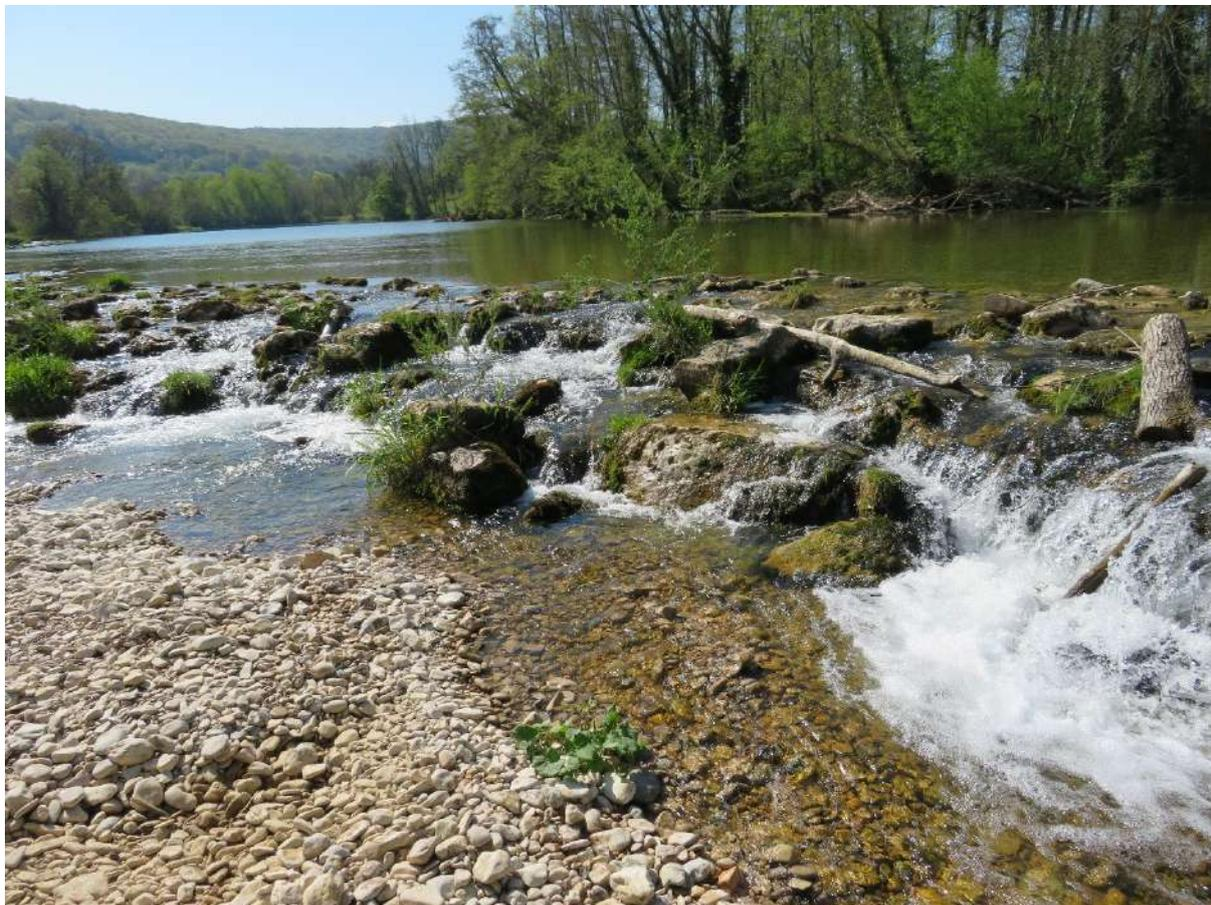
**Figure 54 : Zone de désorganisation des blocs de structure du seuil**
