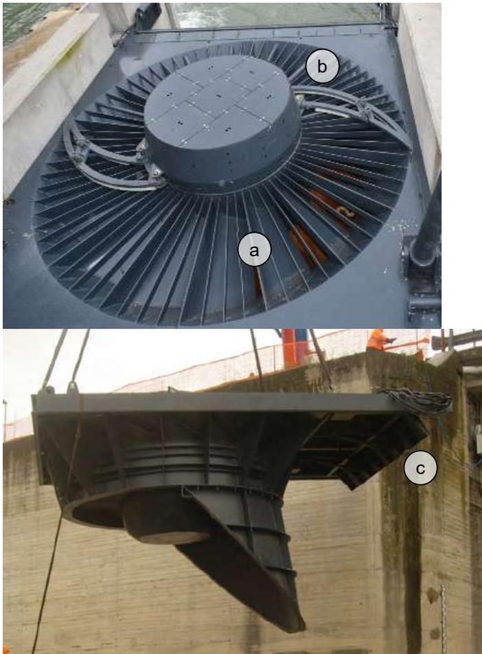
**Figure 63 : Équipements de dégrillage de base d'une VLH**
