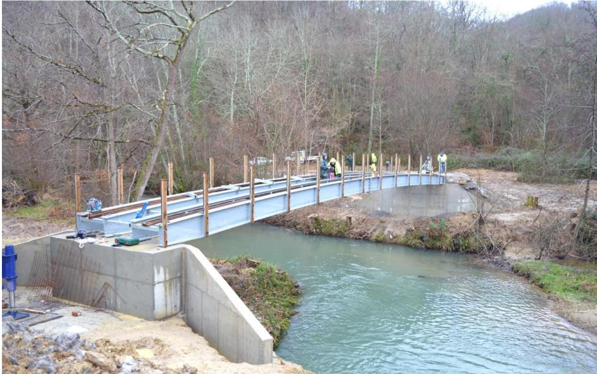
*Figure 3 : Exemple de passerelle sans modification du lit mineur du cours d'eau*
