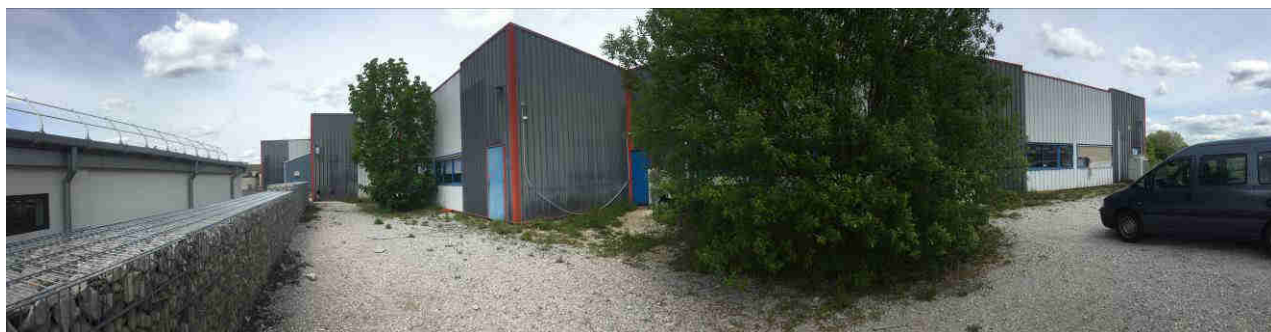
Vue du bâtiment existant (partie conservée) depuis le Sud
