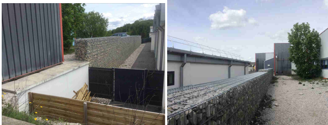
Vues du mur en gabions depuis le Nord et le Sud
