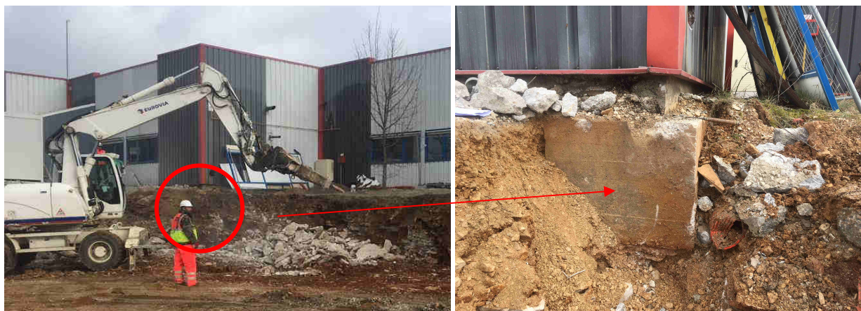
Vue d'une fondation du bâtiment existant (reconnue en 2018)
