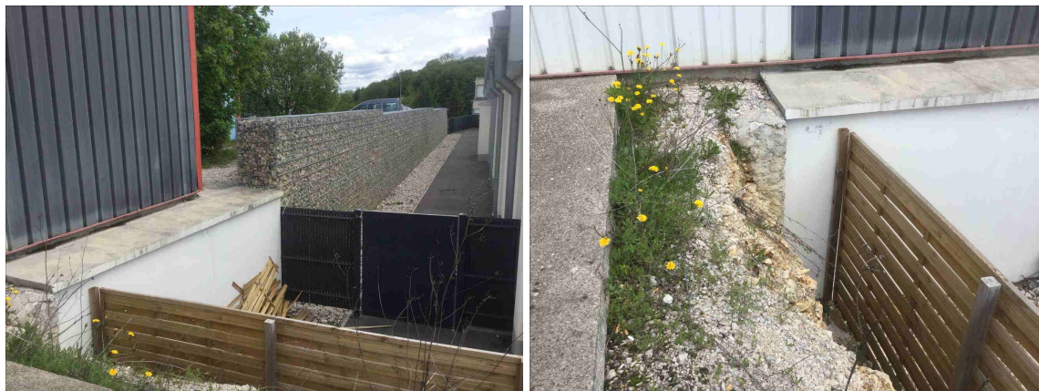
Vue du mur en béton
