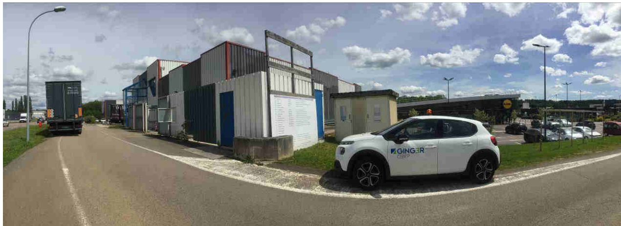
Vue du bâtiment existant à démolir depuis le Nord
