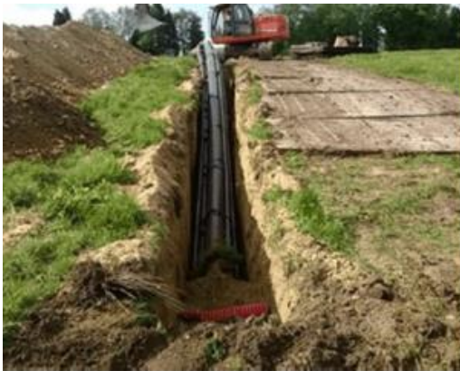
Pose des fourreaux PEHD en pleine terre
