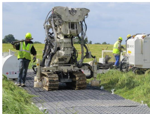
Circulation d'engin sur plaques.
