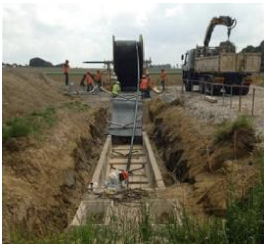
Déroulage des câbles par une chambre de jonction
