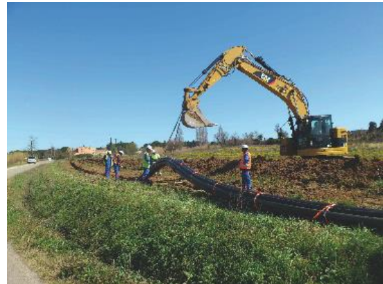
Pose des fourreaux PEHD en pleine terre
