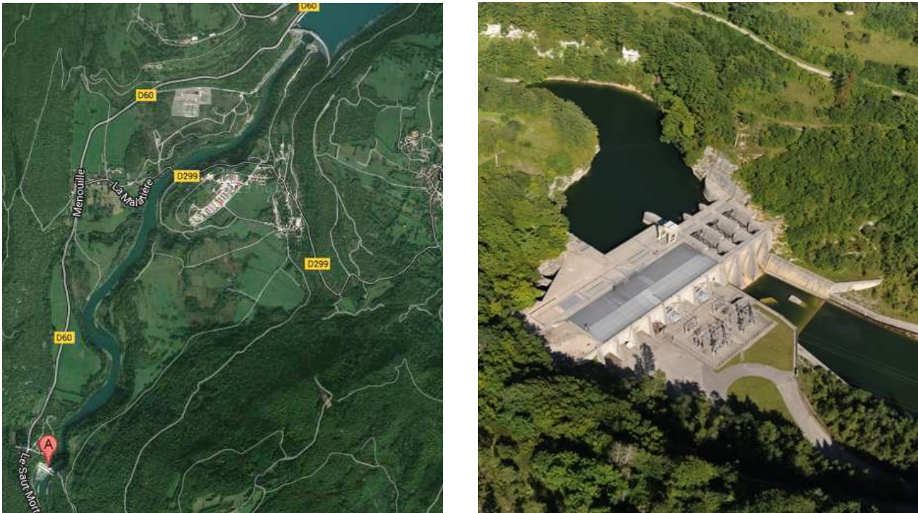
Figure 1 : Plan de localisation du barrage de Saut-Mortier (à gauche, point A) et vue aérienne du barrage de Saut-Mortier (à droite)
