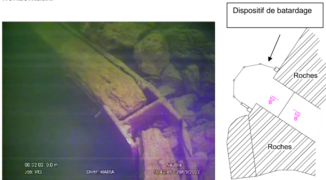
Figure 8 : Photo et plan de situation du dispositif de batardage à l'amont du bouchon de la DP
