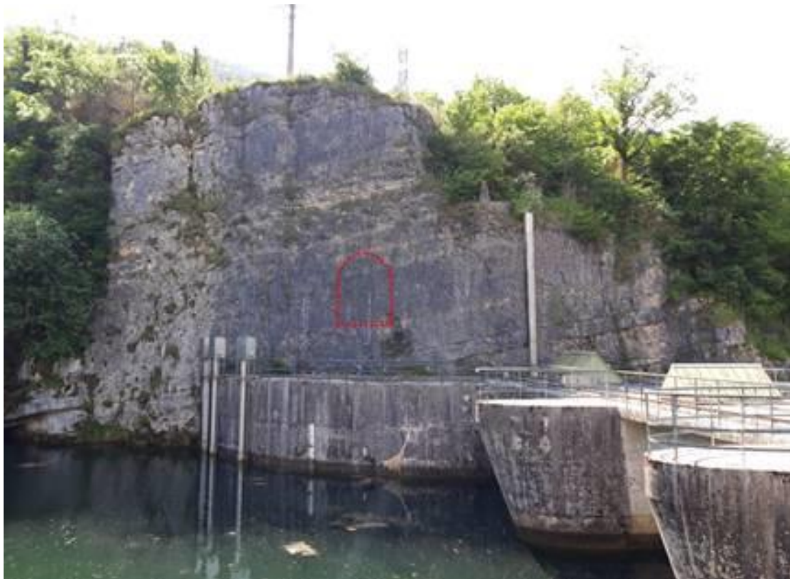
Figure 15 : Vue du merlon rocheux dans lequel la galerie d'accès est creusée
