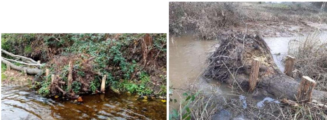
Figure 24 : diversification des écoulements : souche en diversification en berge (source : restauration de la Mare – Fédération de Pêche 42 et restauration du Dévorah – setec hydratec)
