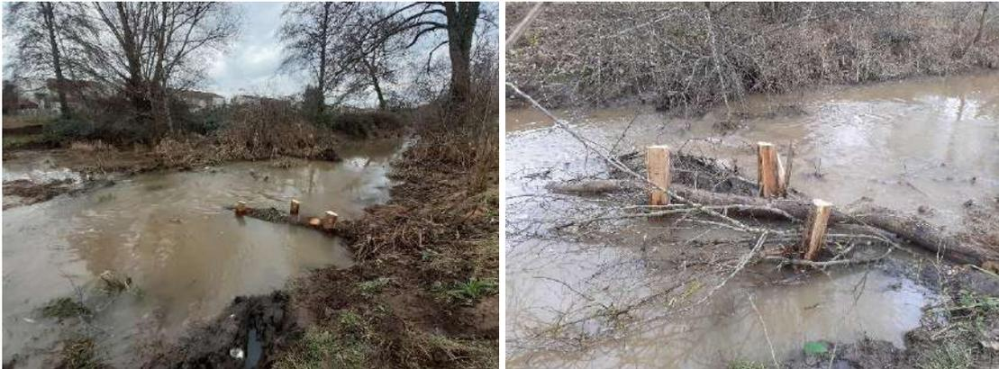
Figure 25 : diversification des écoulements : épis déflecteurs en berge (source : SMABACAB (16) et restauration de la Mare – Fédération de Pêche 42 et restauration du Dévorah – setec hydratec)
