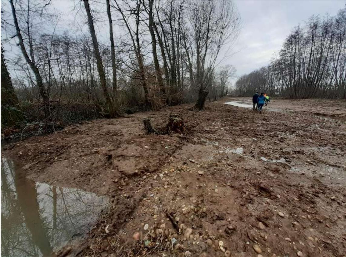
Figure 29 : Exemple de bouchon morainique mis en œuvre dans le lit du cours d'eau comblé (source : setec hydratec – restauration du Dévorah – automne 2023).
