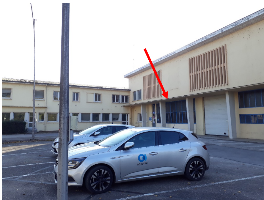
Photographie 1 : Localisation du magasin ENEDIS
