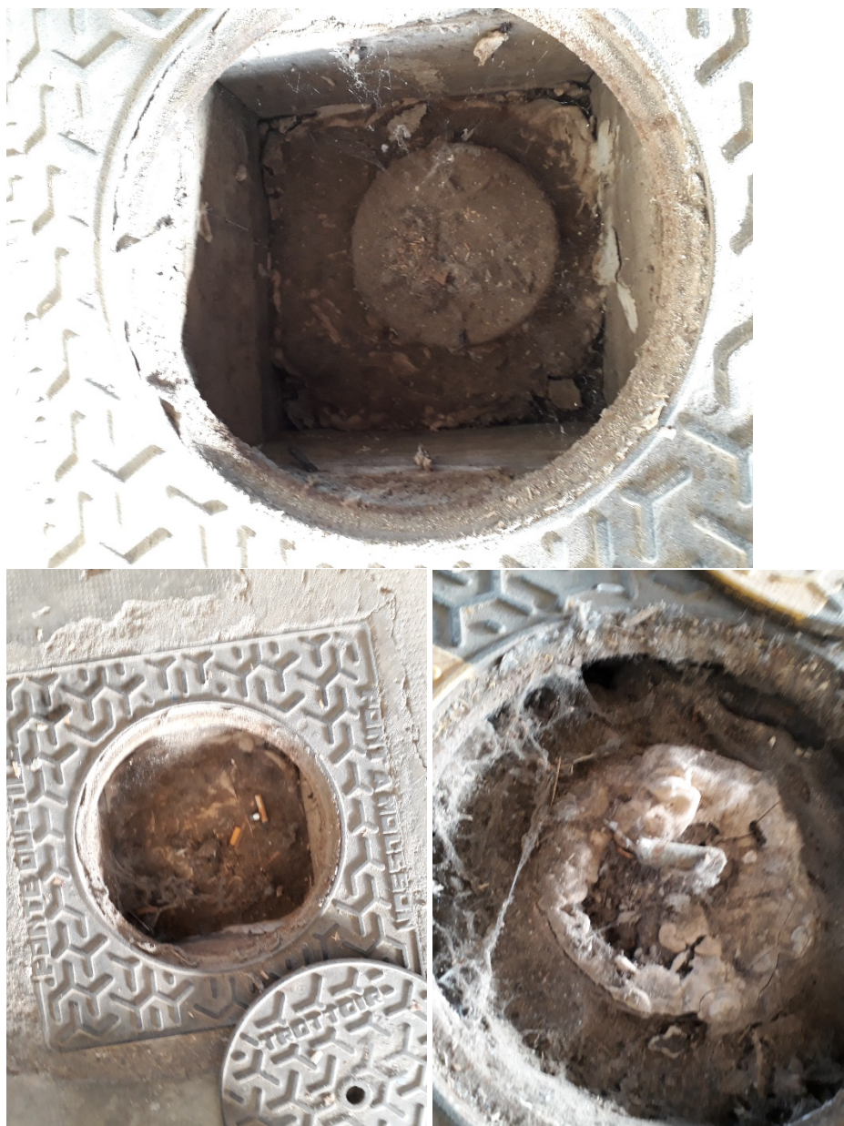
Photographie 3 : Intérieurs des trois regards dans le magasin
