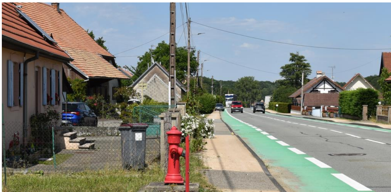
Figure 37 – Route départementale D83 avec sa piste cyclable
