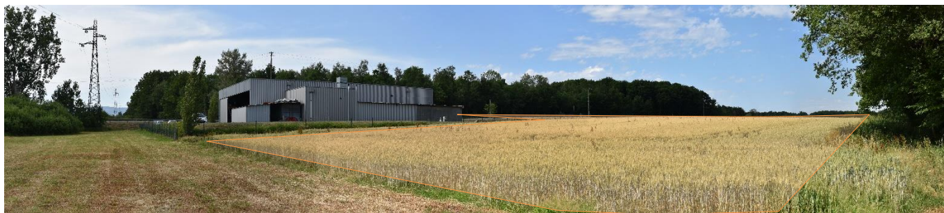
Photographie 19 – Vue sur le site d'implantation n°3 depuis le chemin menant à l'habitation et la parcelle (Eco-Stratégie, 21/06/2022)
