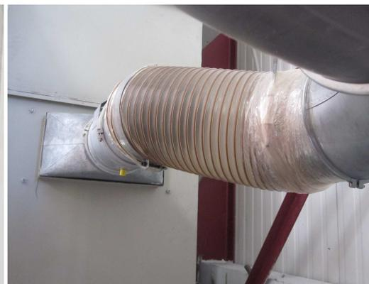
Les émissions de poussières sont cantonnées à l'intérieur des gaines d'aspiration des poussières et dans l'équipement de dépoussiérage, avant les éléments filtrants. Une émission de poussières est possible en aval des filtres en cas d'endommagement de ceux-ci.
