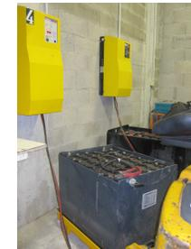
les deux batteries en charge
